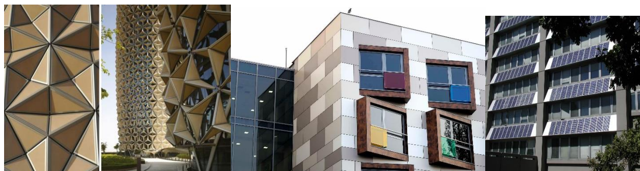
Рисунок 1 - Тип адаптивных фасадных систем: кинетические, термохромные, фотоэлектрические
