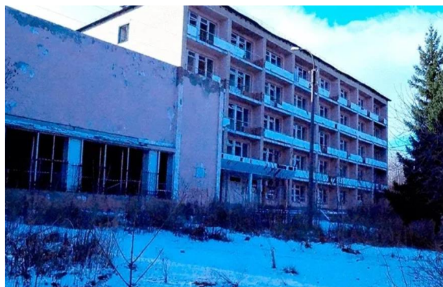
Рисунок 1 - Здание бывшего терапевтического корпуса в г.Кумертау РБ
